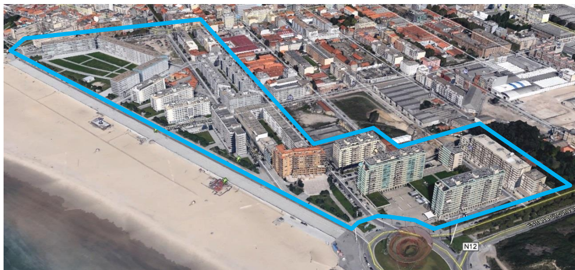
FIGURA 28 | VISTA AÉREA PARCIAL DO SUBSISTEMA 1
