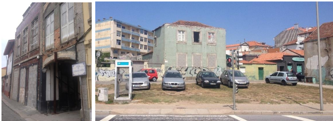
Figuras 51 e 52 - Edifícios devolutos na Rua de Fuzelhas
