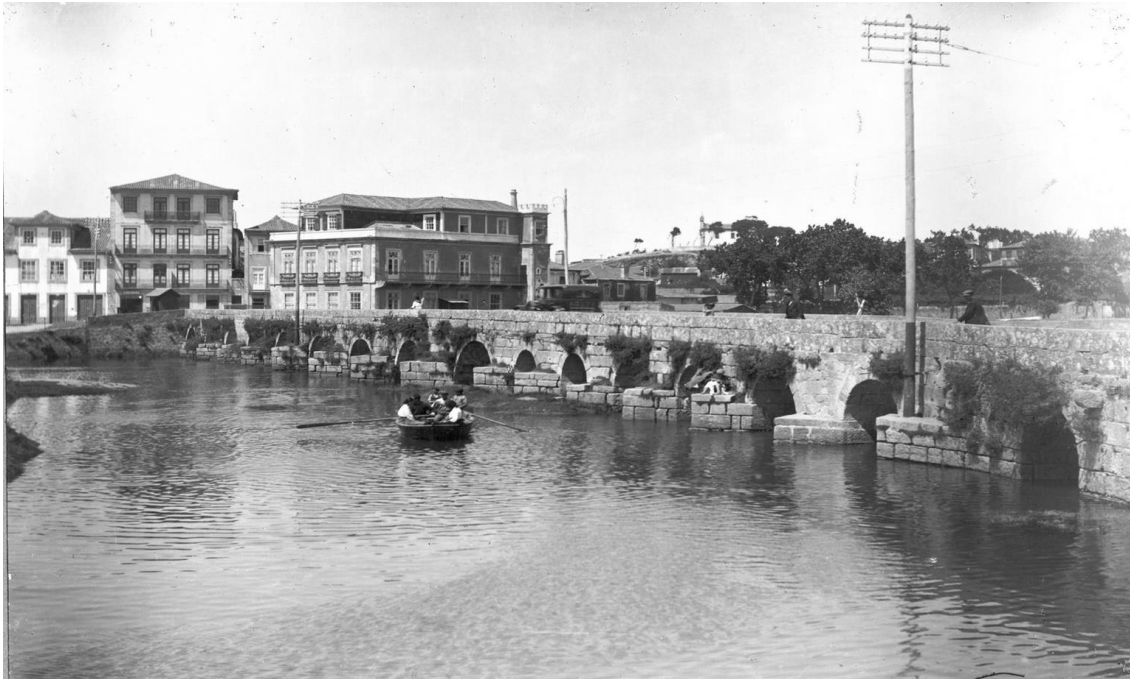
Figura 3 - Leça da Palmeira e a “ponte dos 19 arcos” vista a partir de Matosinhos
