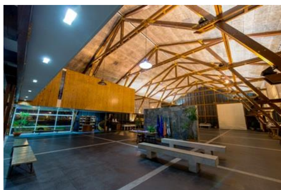
Figura 73 – Estação de Passageiros do Porto de Leixões
