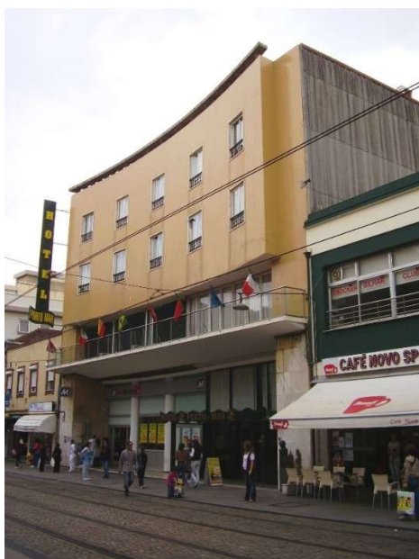
Edifício do Hotel Porto Mar, projetado em 1945, inaugurado em 18 de maio de 1947, construído para Edmundo Alves Ferreira. Localiza-se na Rua Brito Capelo, nº 169. Fotografia do autor, 2011.
